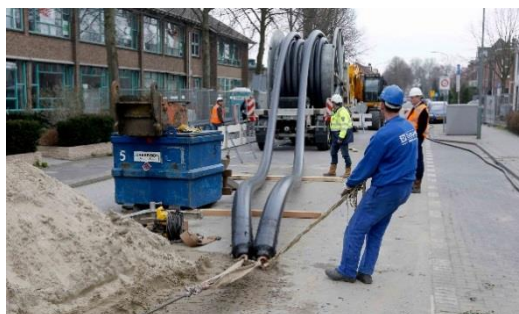
Foto: Thymen Stolk, Aanleg-warmtenet-Bankastraat
